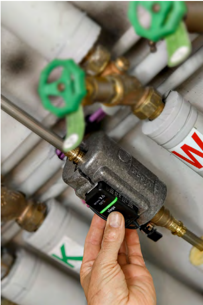
4 Per Tastendruck werden die „AquaVip-Zirkulationsreguliertventile elektronisch“ von Viega voreingestellt und halten von da an den jeweiligen Zirkulationskreis automatisch im thermischen Gleichgewicht zwischen 60 °C und 55 °C.
