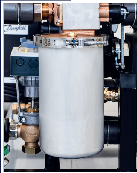
Installierter Impfkristallspender IKS1
